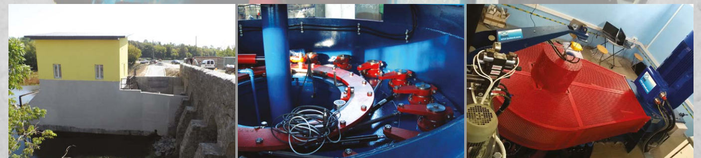
Dostawa i montaż turbiny o mocy 221 kW w elektrowni wodnej Gubyn (Ukraina)
