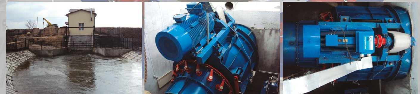
Dostawa i montaż turbiny w elektrowni wodnej Staraya Chortoriya (Ukraina)
