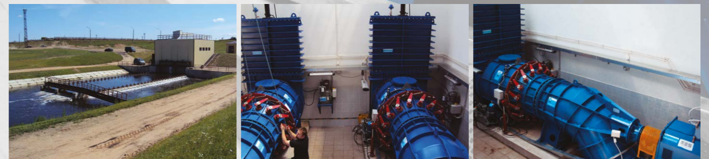
Поставка и монтаж турбин мощностью 2 x 412 кВт на ГЭС Шабаны (Беларусь)
