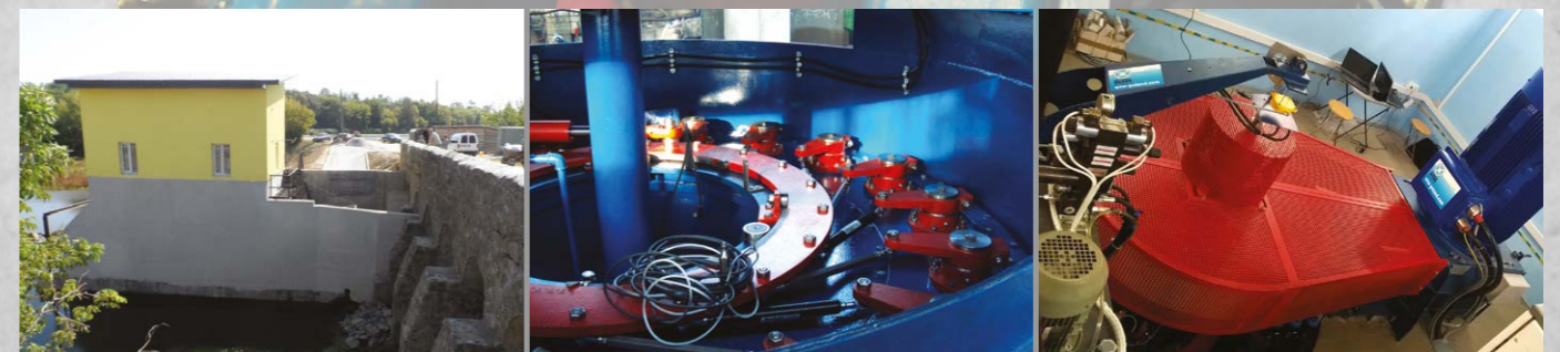
Поставка и монтаж турбины мощностью 221 кВт на ГЭС Губин (Украина)
