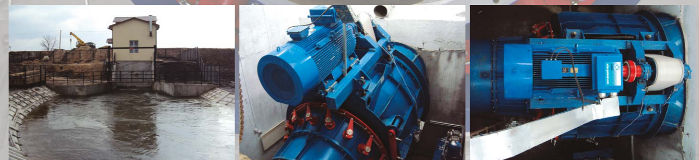
Доставка и установка турбины на ГЭС Старая Чортория (Украина)
